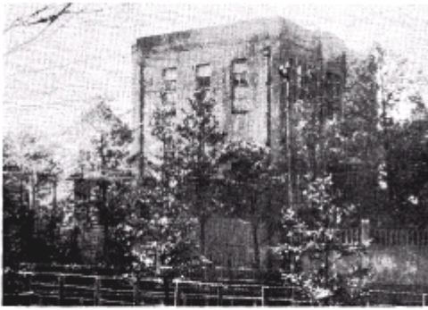
青山南町の乙卯研究所図書館 (2階建、地下1階)
